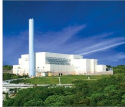
那覇・南風原クリーンセンター発電所
