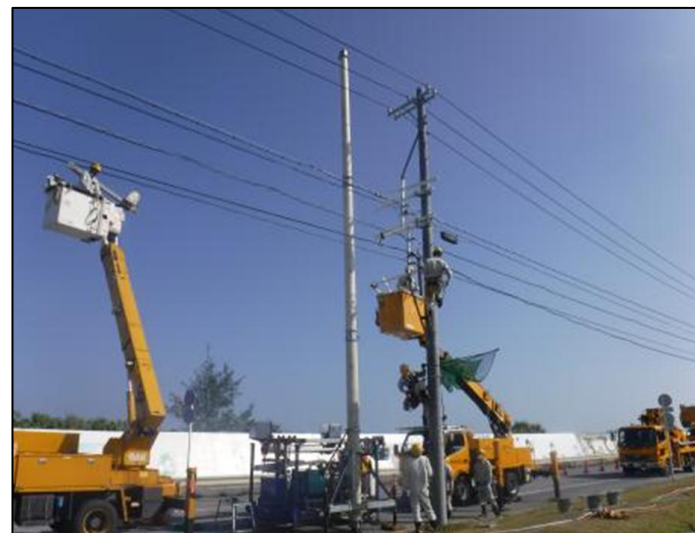
施工業者作業：配電工事
