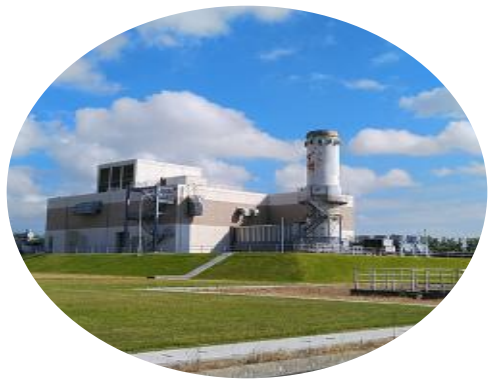
吉の浦マルチガスタービン発電所
