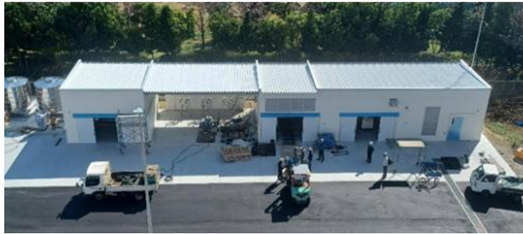
(株)りゅうせき 水電解水素製造施設
