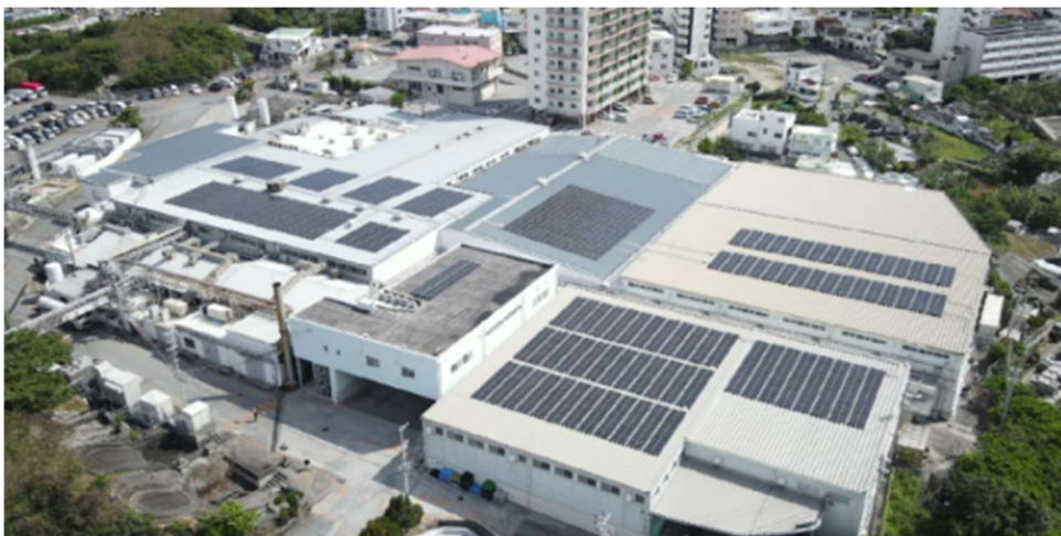
〔かりーるーふ、(沖縄コカ・コーラ浦添工場設置：305kW)〕
