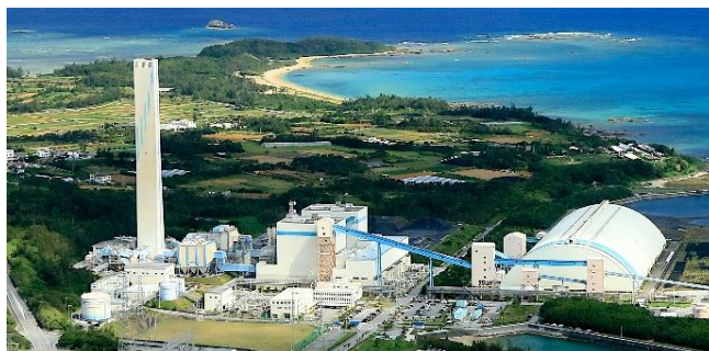
金武火力発電所
