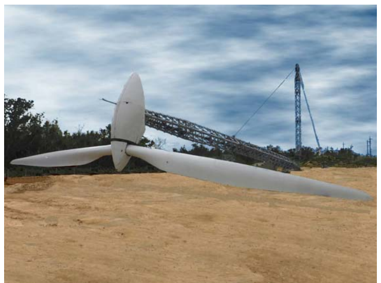
【写真 2：風車傾倒時】
