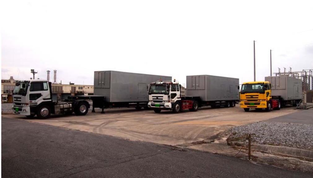
移動用発電設備（ディーゼル） 外観①
