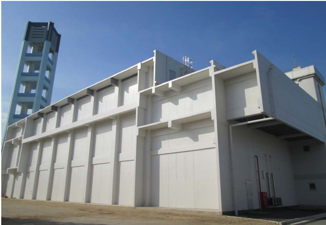
石垣第二発電所 6号発電設備建屋
