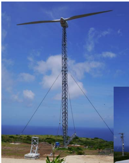
【写真 1：風車全景】
