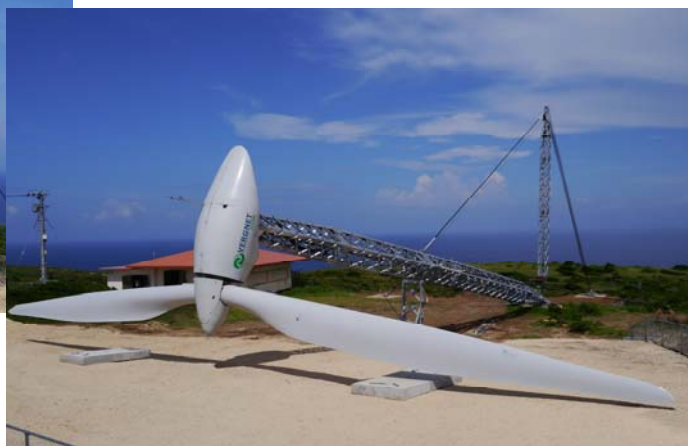
【写真 2：風車傾倒時】
