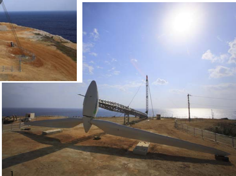
写真 2 風車傾倒時
