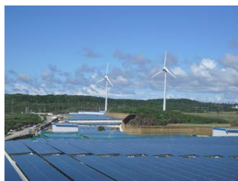
写真1. 宮古島 (H22. 10. 15 完成)
