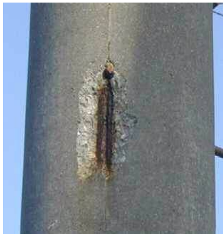
補修前 (剥離部の確認)
