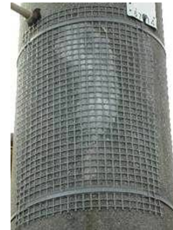
補修後 (剥落防止ネット 取付後)
