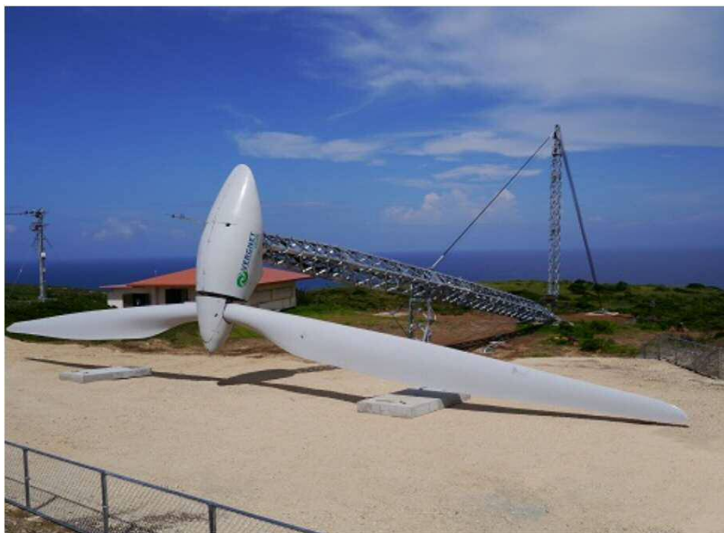
◀ 可倒式風力設備（傾倒時） ▶ 【粟国島】
