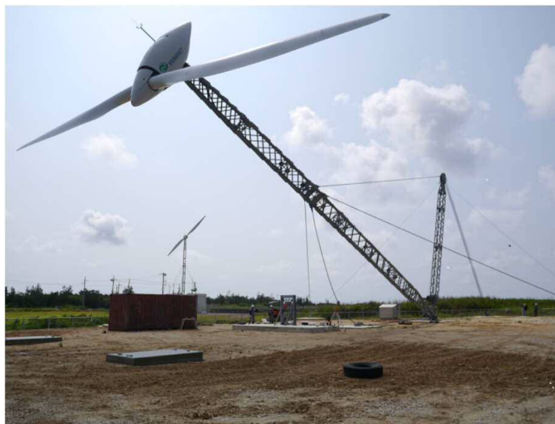
« 可倒式風力設備（傾倒作業中） » 【多良間島】
