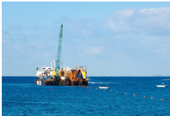
敷設専用台船による敷設状況
