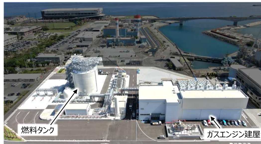
↑ 牧港ガスエンジン発電所全景
