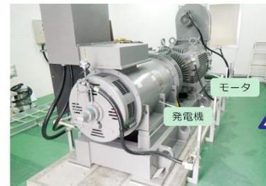
波照間島で風力発電し余剰となった電力を駆動源としたMGセットを利用し、約10日間連続再エネ100%運転を達成
