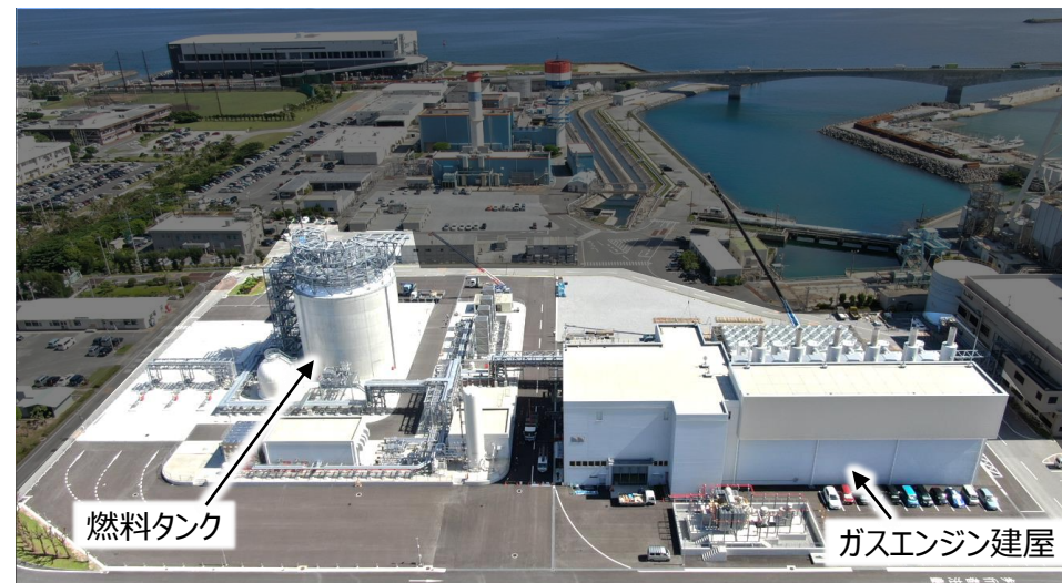
↑ 牧港ガスエンジン発電所全景
