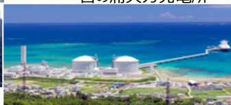
吉の浦火力発電所
