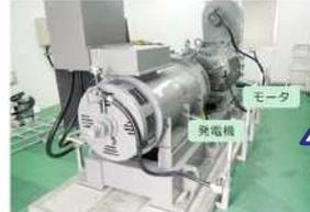
波照間島で風力発電し余剰となった電力を駆動源としたMGセットを利用し、約10日間連続再エネ100%運転を達成
