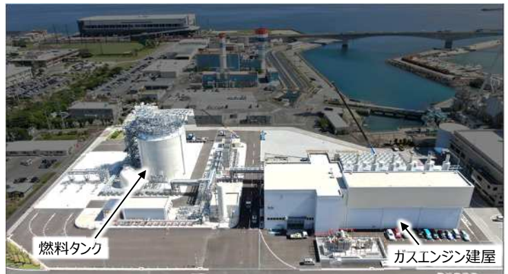
↑ 牧港ガスエンジン発電所全景
