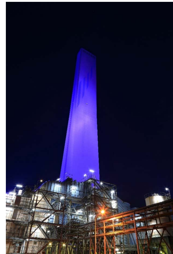
ブルーライトアップ（金武火力発電所）
