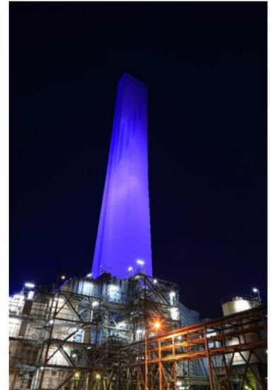
ブルーライトアップ（金武火力発電所）
