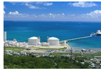
吉の浦火力発電所（LNG）
