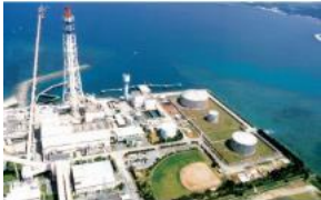
石川火力発電所（石油）
