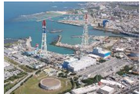
牧港火力発電所（石油）
