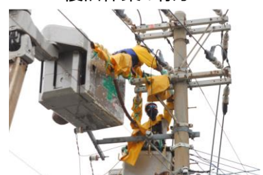
復旧作業の様子
