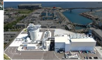
牧港ガスエンジン発電所（LNG）
