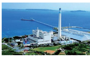
具志川火力発電所（石炭）
