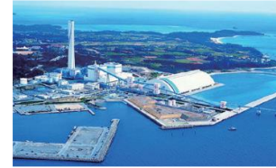
金武火力発電所（石炭）
