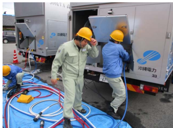
▲当社社員による復旧作業の様子
