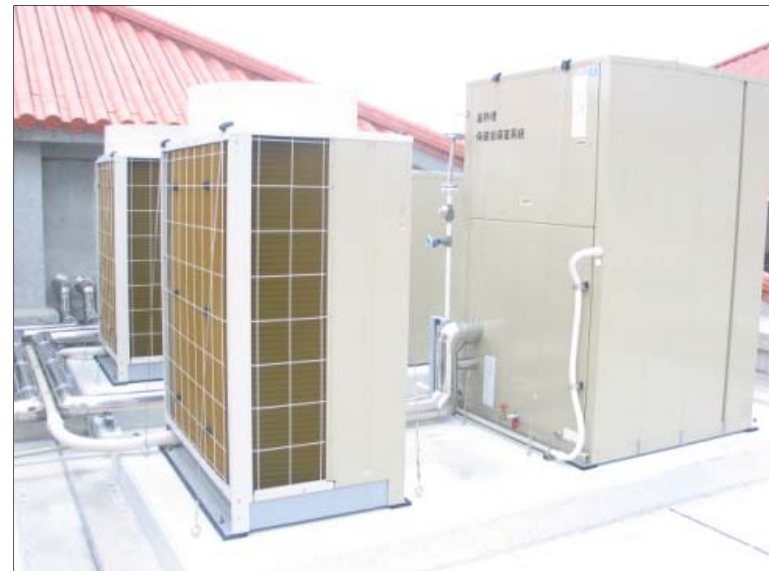
電気式空調システム
