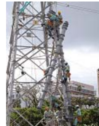
▲鉄塔主脚材取替訓練
