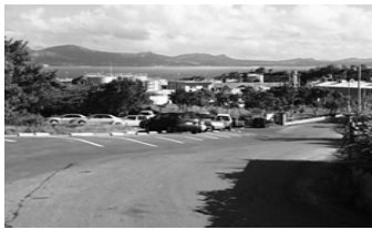
▲駐車場新設工事施工例
