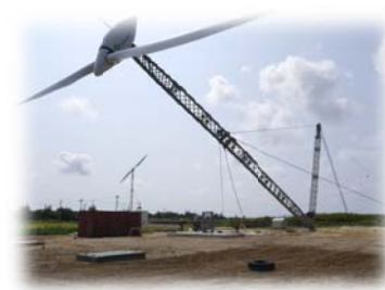
▲可倒式風力設備（傾倒作業中） 【多良間島】
