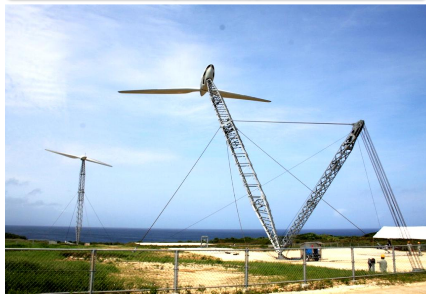
◀可倒式風力設備（傾倒作業中）▶ 【波照間島】
