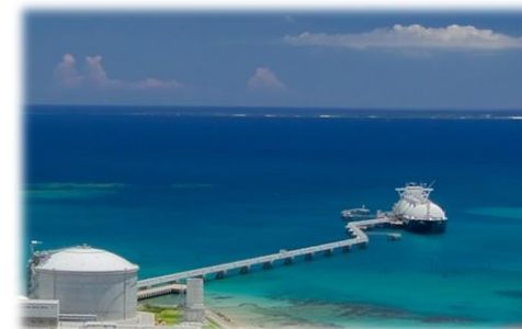
▲吉の浦火力発電所におけるLNG受入
