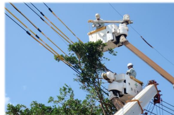
▲日頃の設備巡視、飛来物低減、樹木伐採
