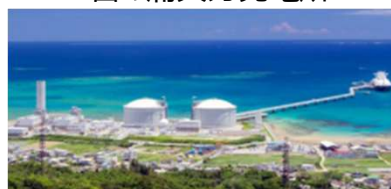
吉の浦火力発電所
