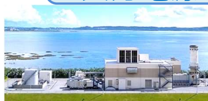
吉の浦マルチガスタービン発電所
