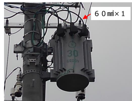
柱上変圧器外観（30 kVA）引上線 ：60 mm 2 × 1 /箇所
