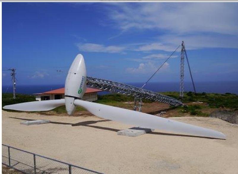
« 可倒式風力設備（傾倒時） » 【粟国島】
