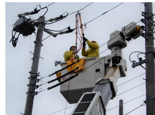
▲ 配電技能競技大会の様子
