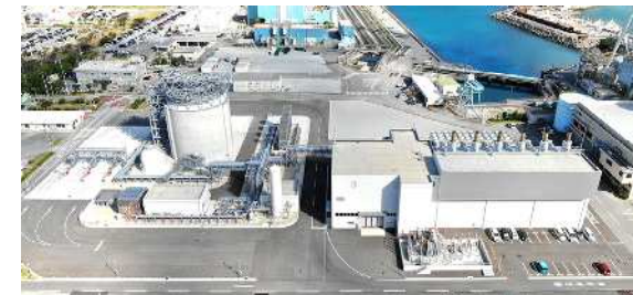
▲牧港ガスエンジン発電所
