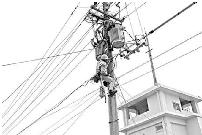
引込線の復旧作業(台風 13 号)
