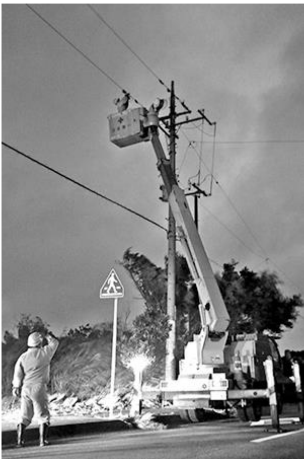
昼夜継続した復旧作業(台風 17 号)
