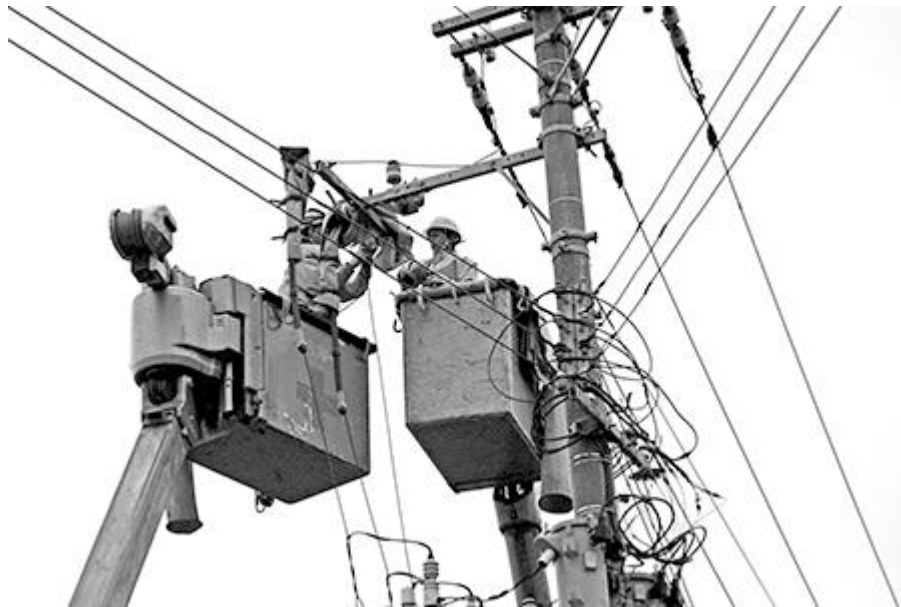
高所作業車での復旧作業(台風 17 号)
