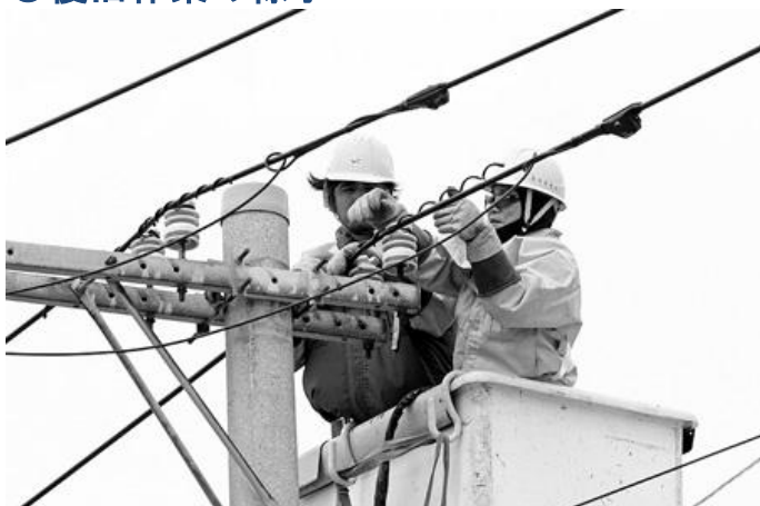
バインド線外れの復旧
