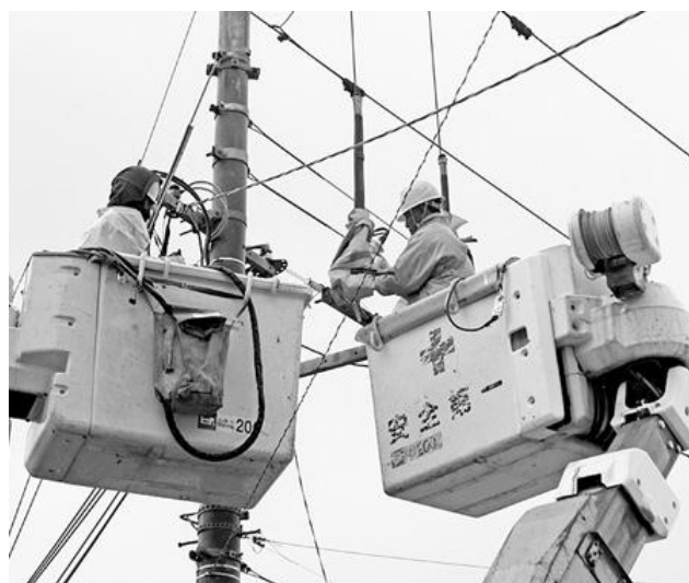
碍子破損の復旧作業
