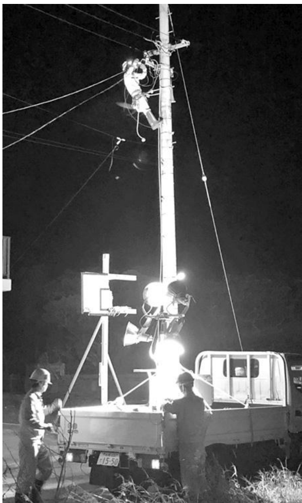
深夜に及ぶ復旧作業
