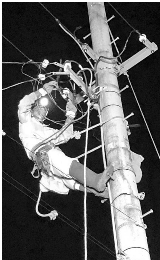
引込線断線の復旧
