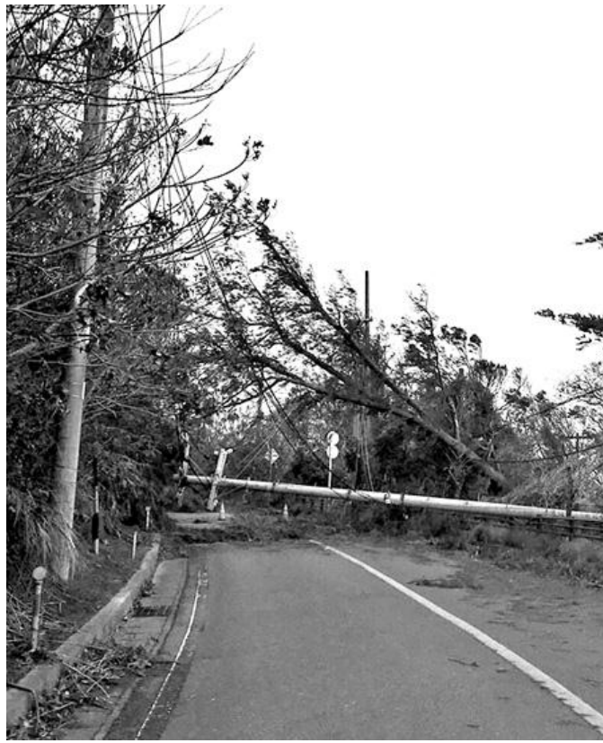
電柱破損
