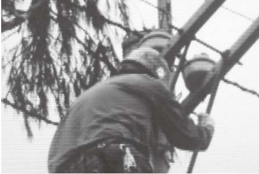
復旧作業の様子(座間味村)
