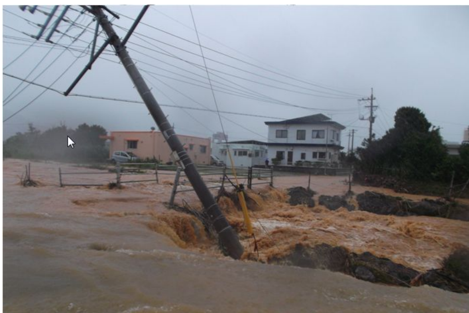
名護市字田井等の電柱傾倒
