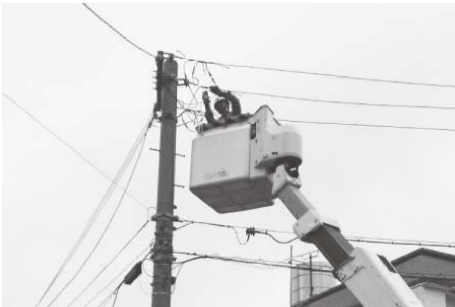
復旧作業の様子(宜野湾市愛知)
