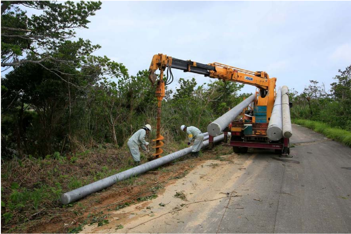
倒壊した電柱を復旧する作業員
