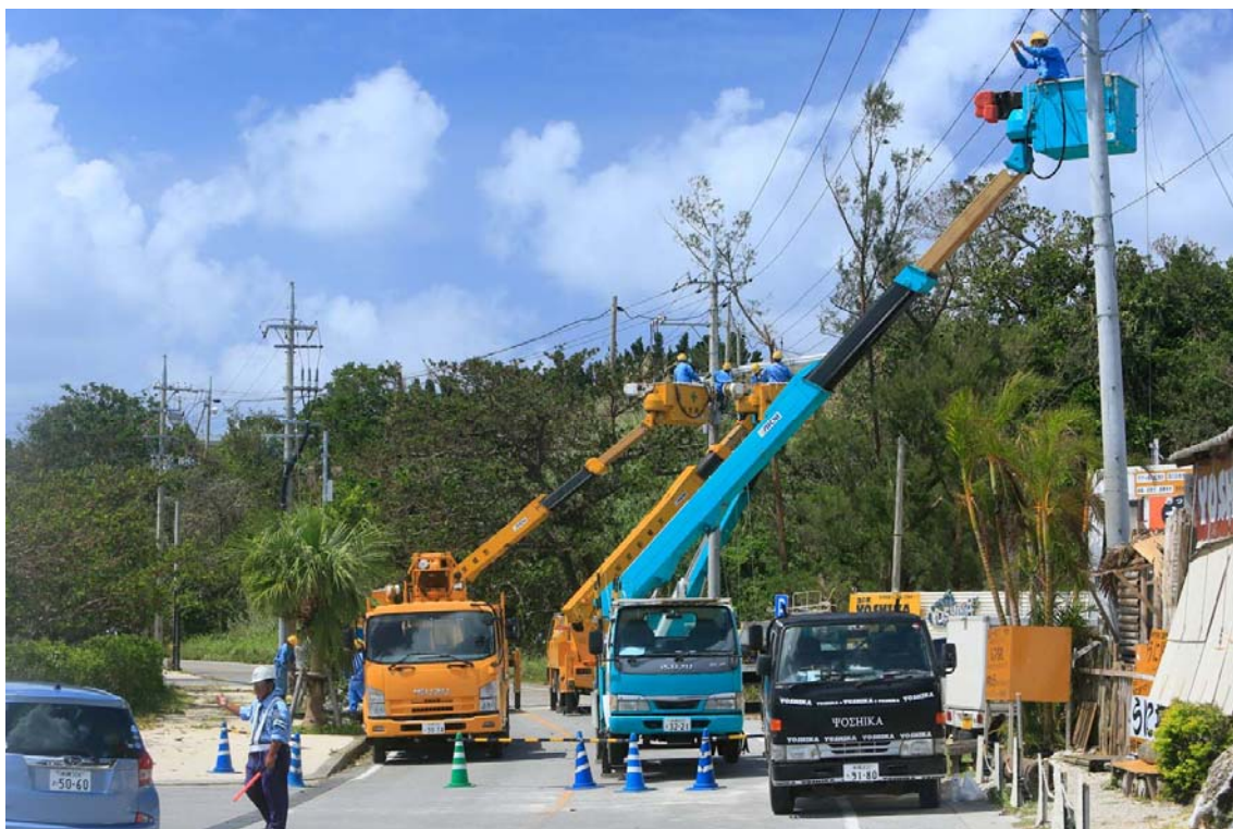
古宇利島での復旧作業の様子
