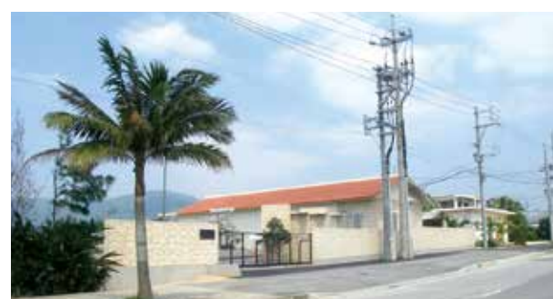
▲名蔵配電塔(石垣島) 「石垣市風景づくり条例」に基づき、赤瓦の屋根を採用し、景観に配慮した建屋外観としました。
