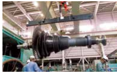
▲吉の浦火力発電所における蒸気タービンの吊り出し
