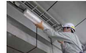
◀LED照明設置工事
