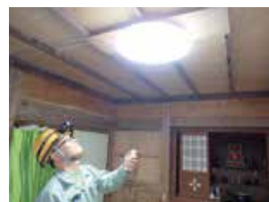
▲地域奉仕活動（電気設備無料点検・修理）
