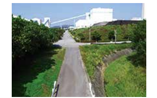
▲ドローンによる撮影(発電所構内)
