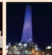
▲金武火力発電所でのブルーライトアップ
