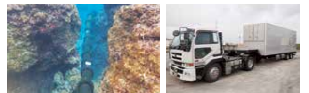
▲渡嘉敷島海底ケーブル敷設状況
