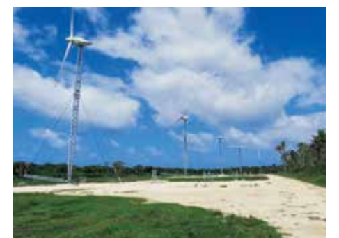
▲トンガ王国へ納入した可倒式風力発電設備
