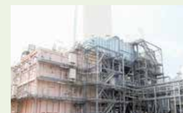
▲排煙脱硫装置
