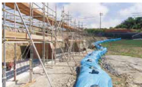
▲赤土等流出防止対策（真壁変電所 建設工事）
