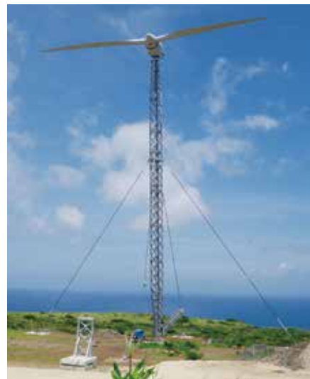
▲粟国可倒式風力発電設備
