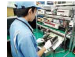
▲計器用変圧変流器の修理
