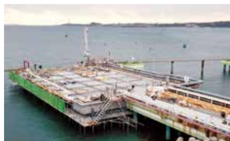
▲海域へのコンクリートがら飛散防止対策（石川火力発電所 揚油栈橋補修工事）
