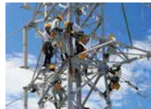
▲架空送電設備の復旧訓練
