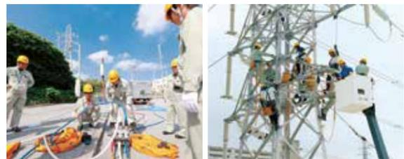
▲高圧発電機を使用した送電供給(仮送電) ▲送電設備(架空)復旧訓練
