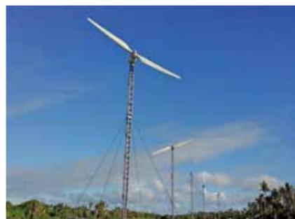
▲トンガ王国へ納入した可倒式風力発電設備
