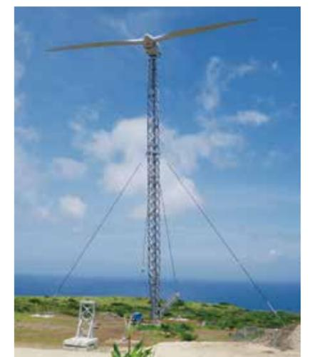
▲粟国可倒式風力発電設備
