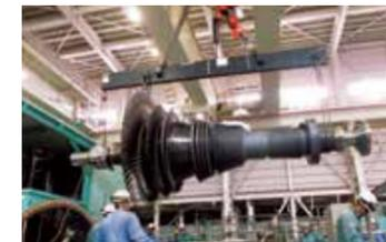
▲吉の浦火力発電所における蒸気タービンの吊り出し
