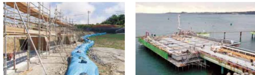
▲赤土等流出防止対策（真壁変電所 建設工事）
