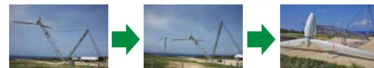
▲波照間可倒式風力発電設備（傾倒時）
