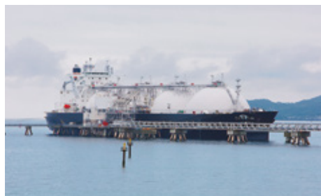
▲LNG船による受入
