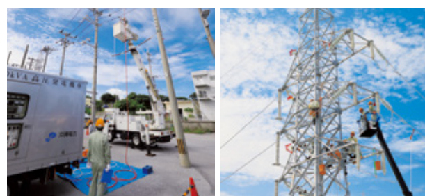
▲高圧発電機を使用した送電供給(仮送電) ▲送電設備(架空)復旧訓練
