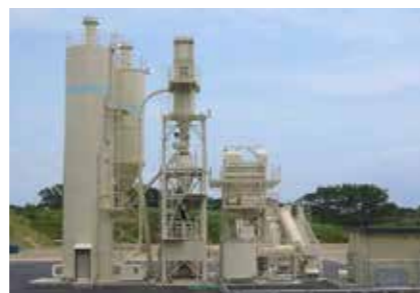
▲頑丈土(がんじゅうど)製造プラント
