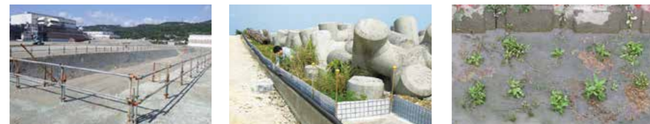
▲赤土等流出防止対策(吉の浦マルチガスタービン発電所 建設工事) ▲オカヤドカリ類保全対策(吉の浦火力発電所 建設工事) ▲建設予定地外に移植後のカワチシヤ(吉の浦火力発電所 建設工事)
