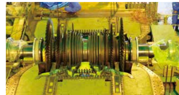
▲長寿命化対策工事を行った石川火力発電所2号機の蒸気タービン
