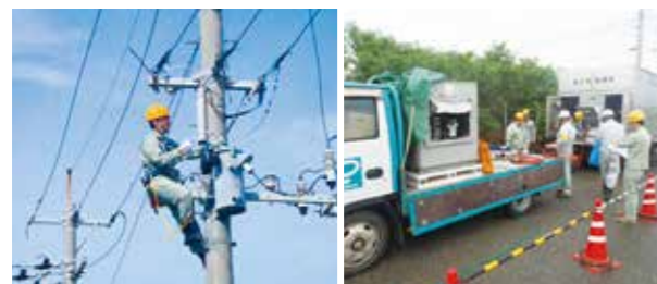
▲配電設備復旧訓練
