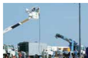
▲高圧発電機車での電力供給訓練
