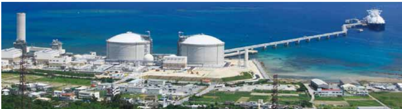
▲高台からの吉の浦火力発電所の眺望
