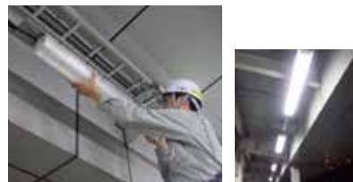
LED照明設置工事▶
