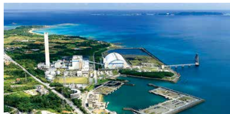
金武火力発電所
