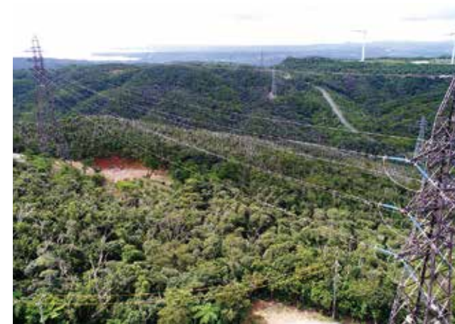
架空送電線路
