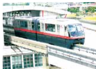
沖縄都市モノレール(株)保守点検工事
