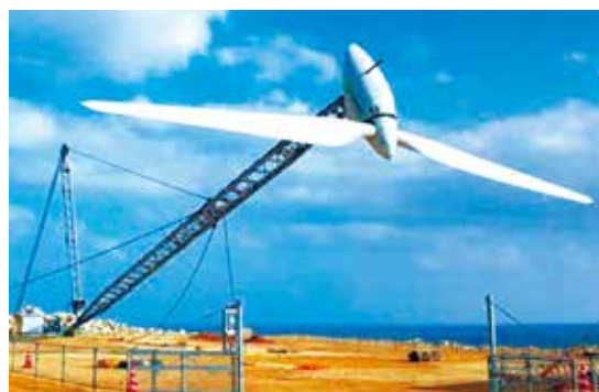
可倒式風力発電システム
