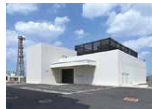
リライアンスエナジー沖縄エネルギーセンター新築工事
