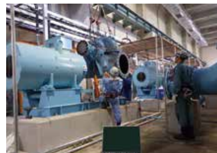
送水ポンプ分解点検
