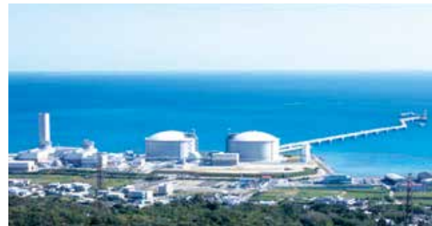
吉の浦火力発電所の全景
