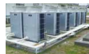
省エネ設備改修工事
