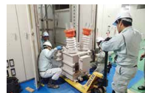
特高VCT取替工事
