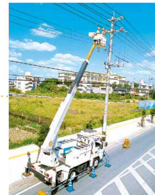
配電設備のメンテナンス
