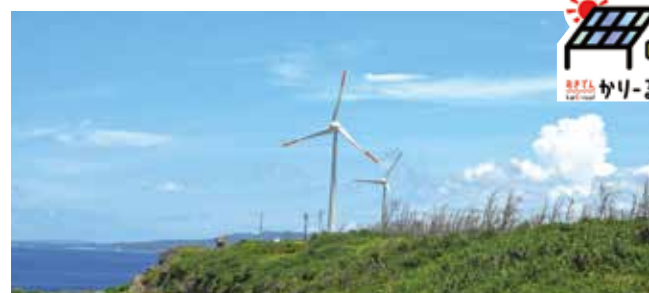
▲伊江島第二風力発電所
