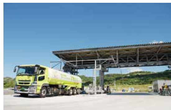
LNG出荷ゲート
