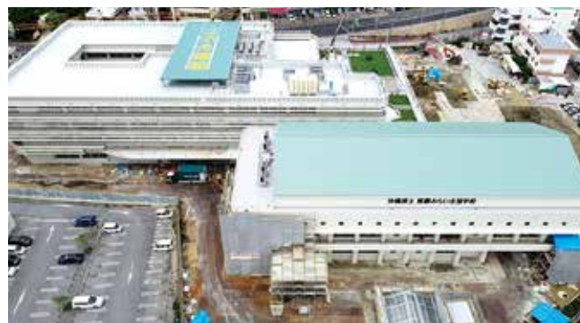
県立那覇A特別支援学校(仮称)新築工事(建築3工区)
