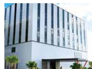
FRT iDCビル
