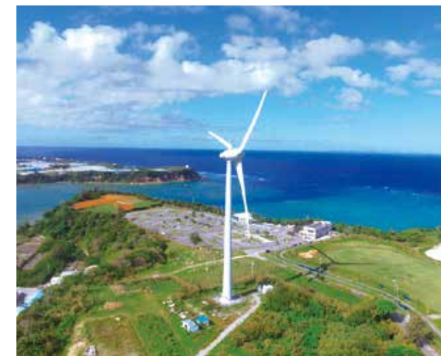
今帰仁風力発電所
