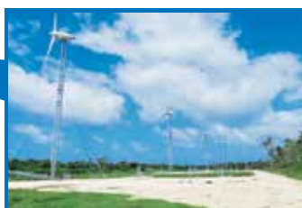
可倒式風力発電設備(トンガ)
