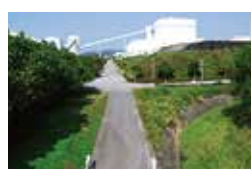
▲ドローンを活用した発電所構内の植生状況確認
