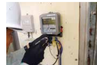
電力量計取替工事
