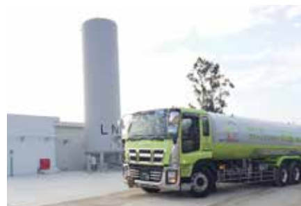
アワセ天然ガス供給センター
