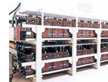
電力貯蔵システム
