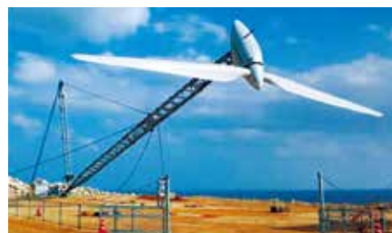
可倒式風力発電システム
