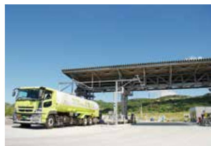
LNG 出荷ゲート
