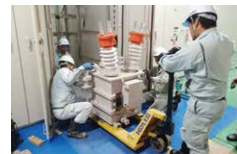
特高 VCT 取替工事
