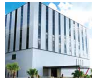
FRT IDC ビル
