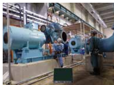
送水ポンプ分解点検
