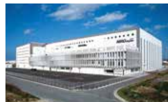
航空機整備基地新築工事 (事務所棟建築4工区)
