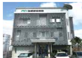
沖縄給油施設新社屋新築工事
