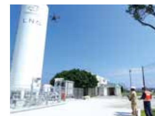
ドローンを用いた設備点検
