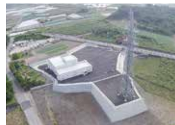
真壁変電所新設工事
