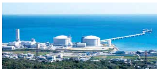
吉の浦火力発電所の全景
