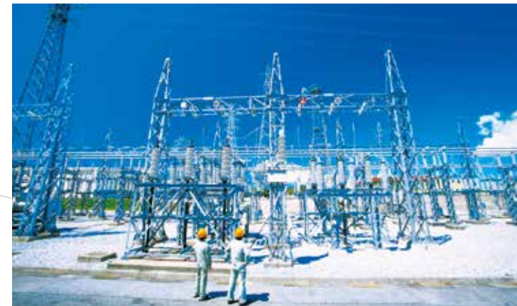
栄野比変電所
