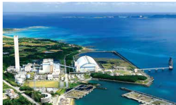
金武火力発電所
