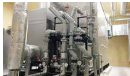
自家用発電システム
