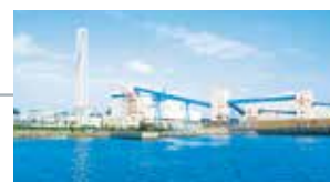
金武火力発電所
