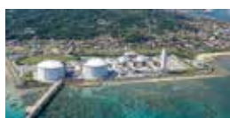
吉の浦火力発電所
