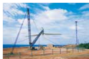
可倒式風力発電設備（南大東島）
