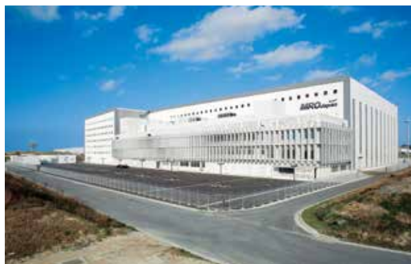
航空機整備基地新築工事（事務所棟建築4工区）：(株)沖縄電工
