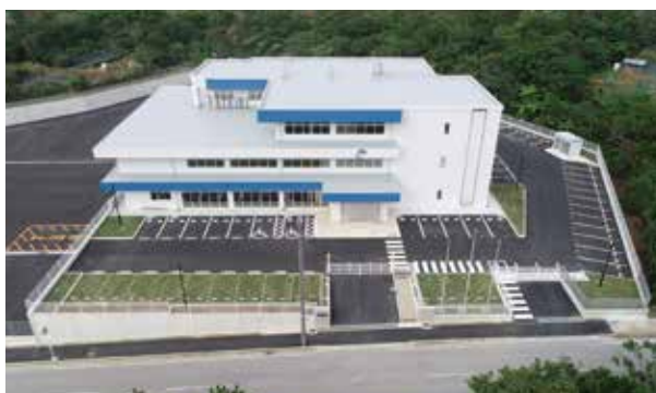
おきでん名護ビル新社屋：沖縄開発(株)（設計：(株)沖縄エネテック・施工：(株)沖縄電工）
