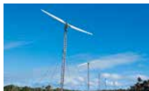
トンガ：可倒式風力発電所（275kW×5基）
