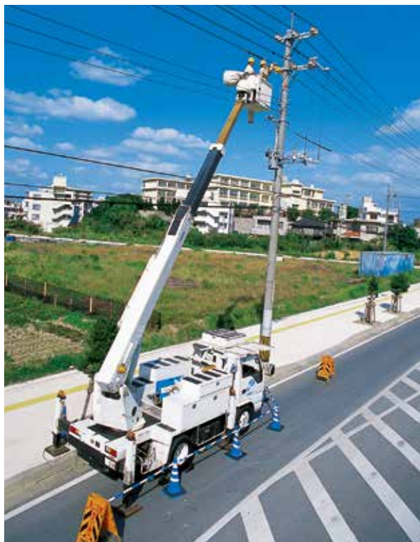
配電線のメンテナンス
