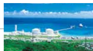
吉の浦火力発電所
