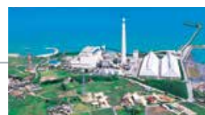
具志川火力発電所
