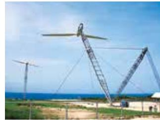
波照間可倒式風力発電設備
