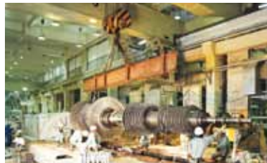
沖縄電力 牧港火力発電所タービン点検分解 沖縄プラント工業(株)
