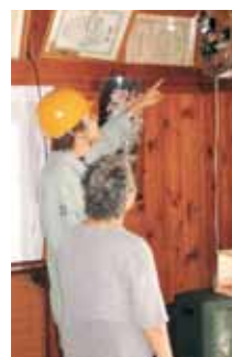
独居老人世帯の屋内配線点検・修理
