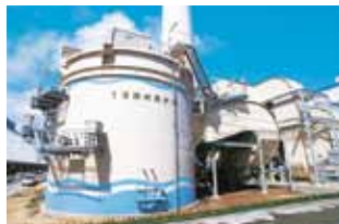
発電所の環境保全対策設備 排煙から有害物質を取り除くため、脱硫・脱硝装置で環境保全対策を講じています
