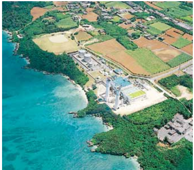
宮古第2発電所
