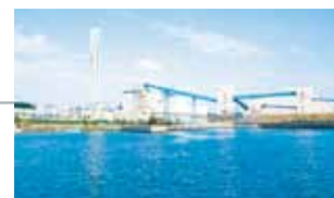
金武火力発電所
