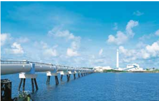
具志川火力発電所
