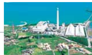
具志川火力発電所
