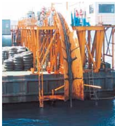
海底ケーブル敷設工事
