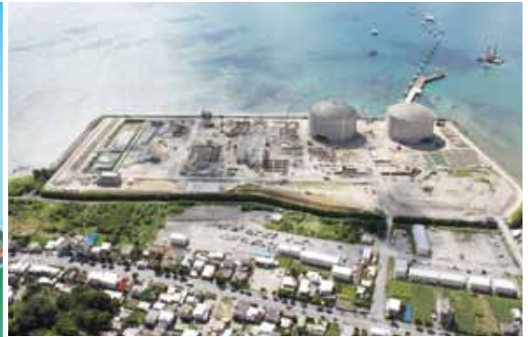
吉の浦火力発電所建設現場
