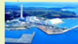
金武火力発電所(2002年運用)
