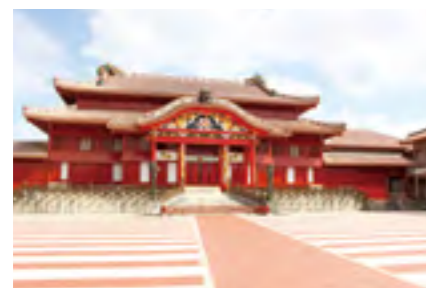
首里城正殿 復元 (2026 年竣工予定)
