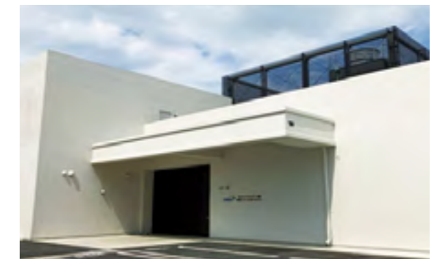
牧港エリアエネルギーセンター(エネルギーの面的供給)
