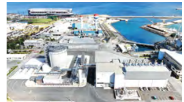
牧港ガスエンジン発電所
