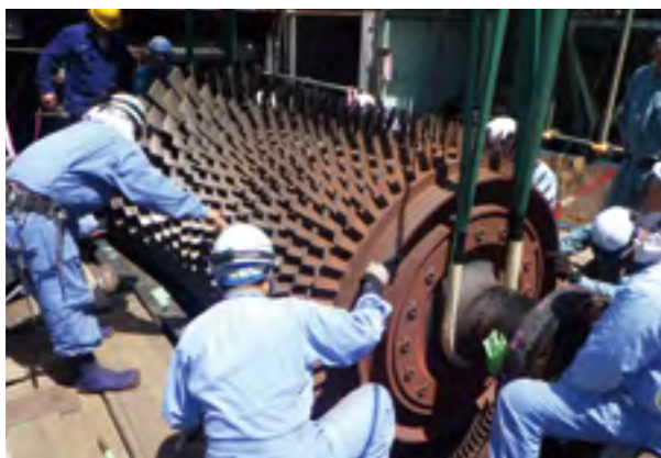
牧港火力発電所ガスタービン点検：沖縄プラント工業(株)
