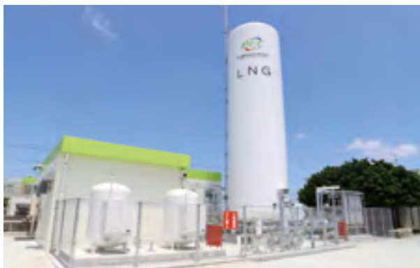
牧港天然ガス供給センター：(株)プログレッシブエナジー (設計：(株)沖縄エネテック・施工(基礎工事)：沖電開発(株))
