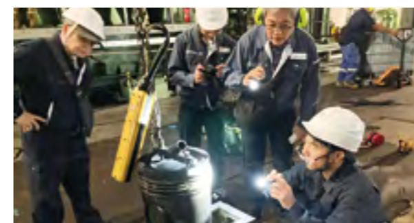
ディーゼル発電機の調査
