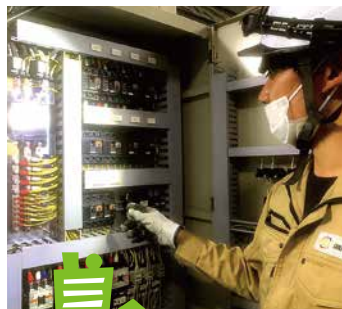
制御装置点検
