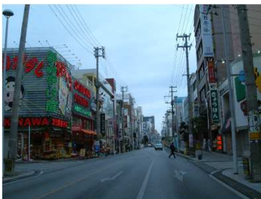
《無電柱化整備前》
