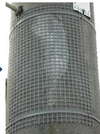
補修後 (剥落防止ネット取付後)
