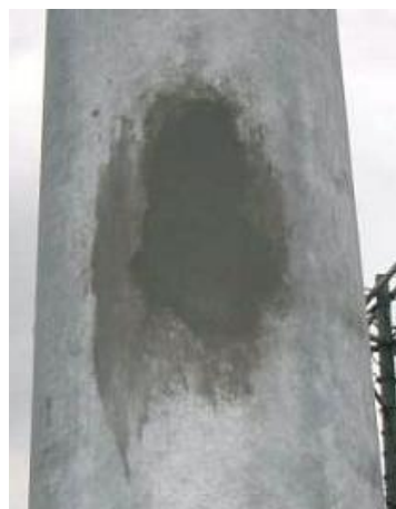
補修後 (剥離部への補修材 盛り込み後)
